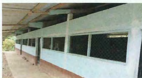
Foto 4: Cambio de ventanas del Modulo de COPB anexo a EORM con PVC Color Blanco correrizo con vidrios reflectivos azul de 5mm.
