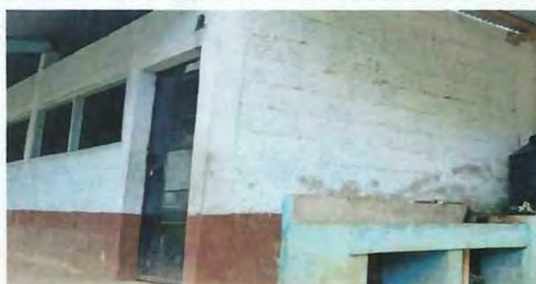
Foto 3: Cambio de puertas del Modulo de COPB anexo a EORM con metal con llave de chapas.
