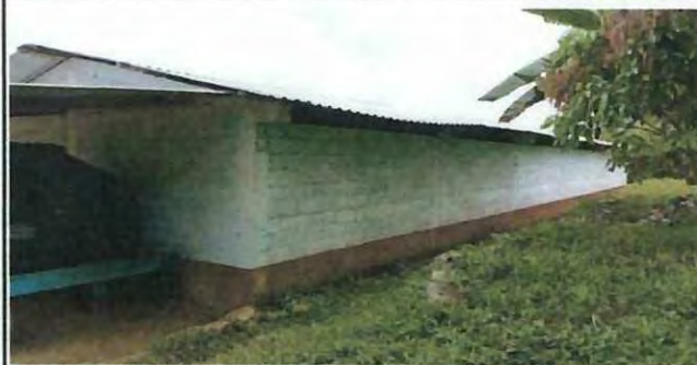
Foto 8: Repello de paredes del módulo interior y exterior de la COPB anexo a EORM.
