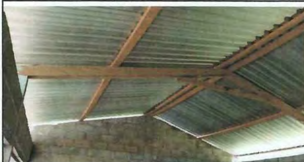
Foto 2: Cambio de Estructura de Techo del Modulo de COPB anexo a EORM con costaneras y tubo de metal.
