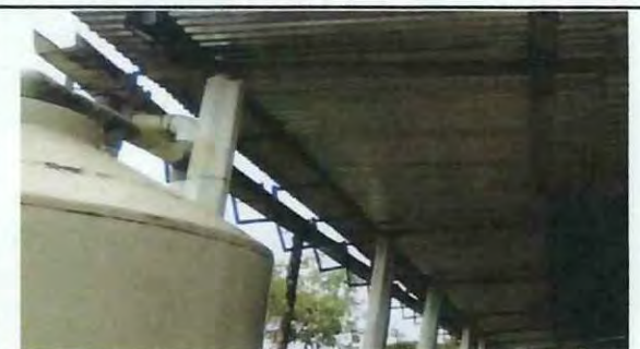
Foto 5: Cambio de Canelesy bajadas de Agua Pluvial del Modulo de COPB anexo a EORM con Canal T/Americano C26.
