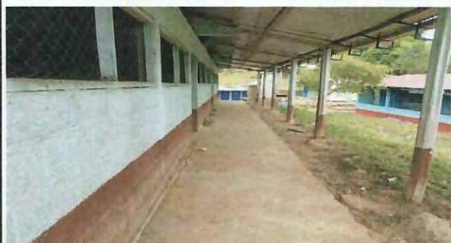
Foto 7: Reparación del corredor del módulo de la COPB anexo a EORM.
