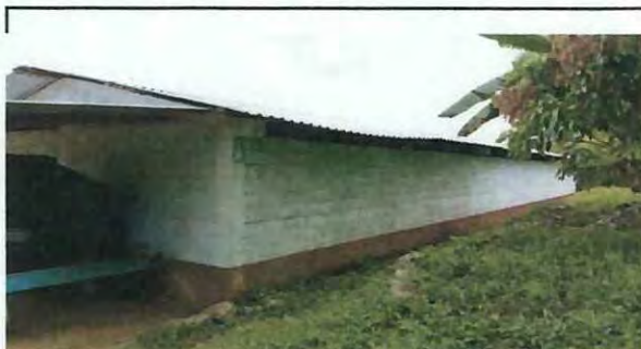
Foto 6: Pintura de muros Interior y exterior del módulo COPB anexo a EORM con color celeste nacional y azul nacional el zócalo.
