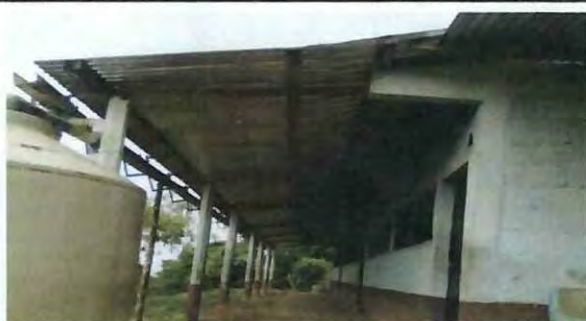
Foto 1: Cambio de entechado del modulo de COPB anexo a EORM con Láminas MAXALUM C26.
